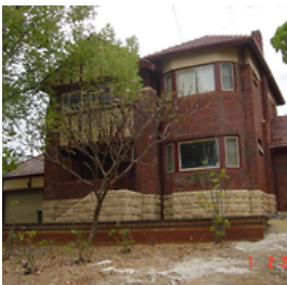
Victoria Park (Riverbank) Annexe
